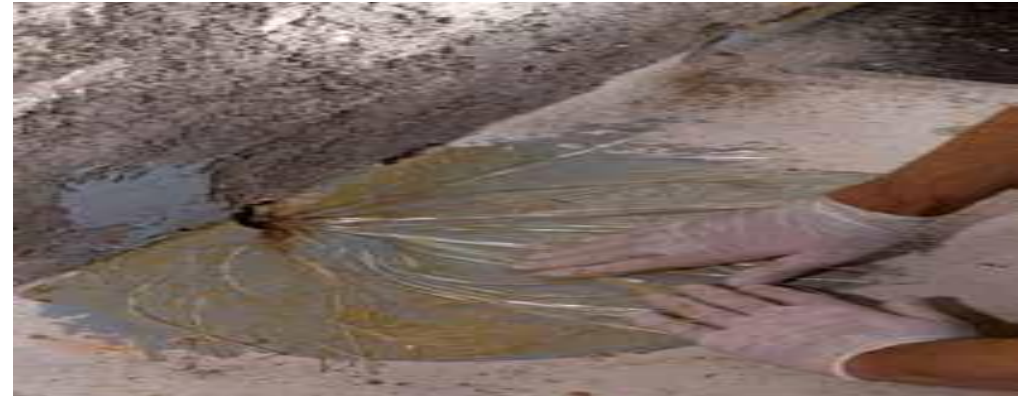
Aplikim real 'wet layup' i fletës CFRP (sistemi MapeWrap).
