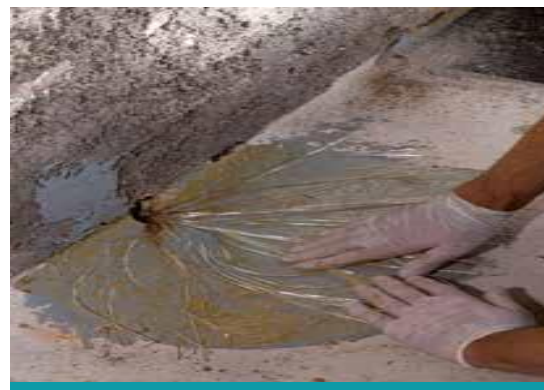
Aplikim 'wet layup' i fletës CFRP
